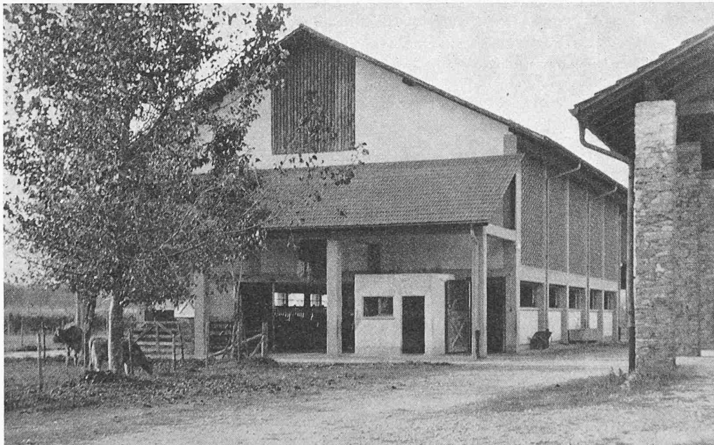
Ansicht aus Südosten. Unter dem Vordach nachträglich, im Zusammenhang mit der Einführung der Melkmaschine, eingebaute Milchkammer
