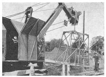
Heidbreder-Kanalbohlen-Einbaugerät beim Ziehen des Einbaukorbes
