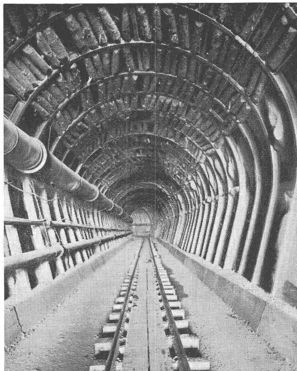
Stollen mit Stahleinbau in gebrächem Fels
