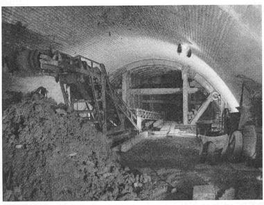
Bild 15. Tunnelbau in der Kies- und Moräne-Strecke, Einbau mit Leichtmetall-Lehrbögen (Foto W. Müller, Baden)
