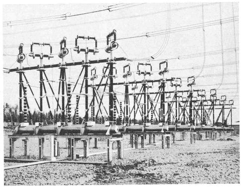
Bild 5. 400-kV-Druckluftschnellschalter in einer finnischen Anlage. Mit den günstigen Schalterabmessungen konnte die Anlage einfach und übersichtlich gebaut werden.
