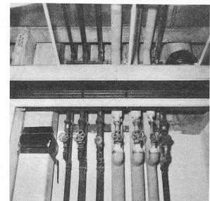
Bild 5 (links). Blick von unten in den Leitungskanal über dem Gang bei weggenommener Zwischendecke (vgl. hierzu Bild 4). Rechts unterhalb der Zwischendecke ist der geschlossene Kanal für die Verteilung der elektrischen Energie 220/380 V mit eingebauten Leitungsschutzautomaten sichtbar
