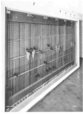
Bild 7. Der Hauptlinienwähler im Gang des Zweiten Obergeschosses. Darüber der mit Deckeln verschlossene Blechkanal zur Verteilung der elektrischen Energie 220/380 V
