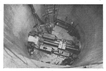
Ausführungen der Horizontalbohrungen für eine Grundwasserfassung
