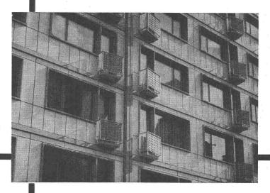
Ausfachung eines Beton-Skelettbaues
