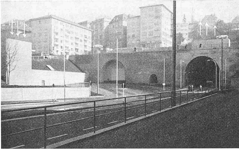
Bild 8. Westportal, links Frischluft-Absaugung, über dem Portal Abluft-Ausstoss, und Bild 10 (rechts) Schalldämpfung in den Ansaug- und Ausstosskanälen
