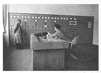
Bild 9. Schaltzentrale im Betriebsgebäude beim ostseitigen Tunnelende
