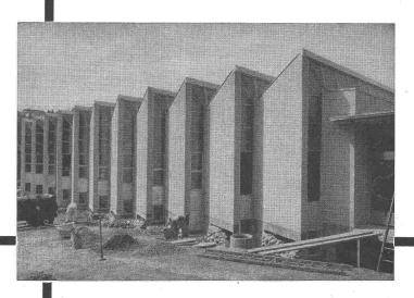
Eisenbetonbau, vollständig mit PORA-Platten ummantelt
