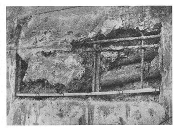
Bild 3. Kiesnest in einer Zone, in welcher der Beton nicht einwandfrei eingebracht und verarbeitet werden konnte
