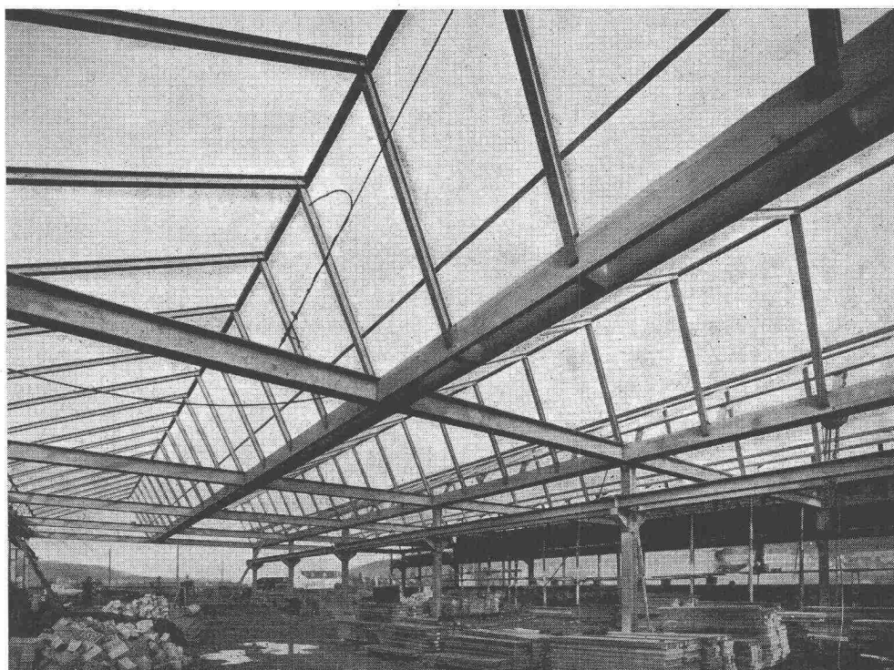
Shedbau, vollständig geschweisst
