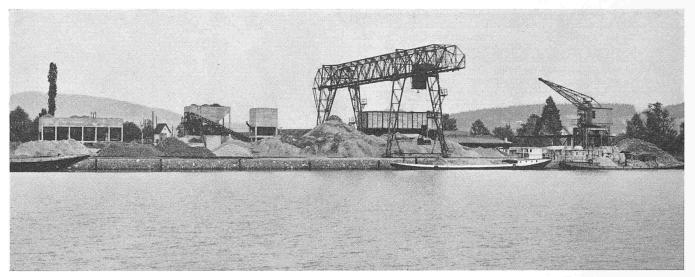
Gesamtansicht der Werkanlagen in Horw. Von 1. nach r.: Siloanlage, Dosieranlage, Verladekran, Drehkran
