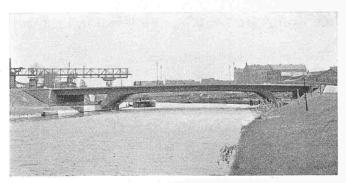
Caprivibrücke über die Spree, Spannweite 61 m
