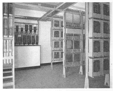
Bild 5. Teilansicht des Relaisraumes, Rechts die Gestellgruppen der steckbaren Relaissätze, Am linken Bildrand erkennt man ein Gestell der Gleisrelais, im Hintergrund die Kabelendverschlüsse
