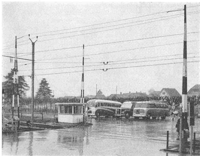
Bild 2. Uebergang 3 (Unterseen). Man erkennt drei der vier vorhandenen Barrieren-Antriebe; alle in geöffneter Lage. In der Bildmitte ist der Wärterposten ersichtlich, von dem aus die Barrieren dieses Ueberganges bei starkem Strassenverkehr bedient werden
