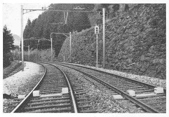
Bild 6. Impulsgeber für Achszählung an der Blockstelle einer zweigleisigen Bahnlinie
