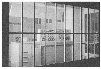
Bild 2. Elektrisches Freigabewerk Schaffhausen, Zehn Schalter auf eine Länge von 1,60 m (ohne mechanische Verschlüsse)
