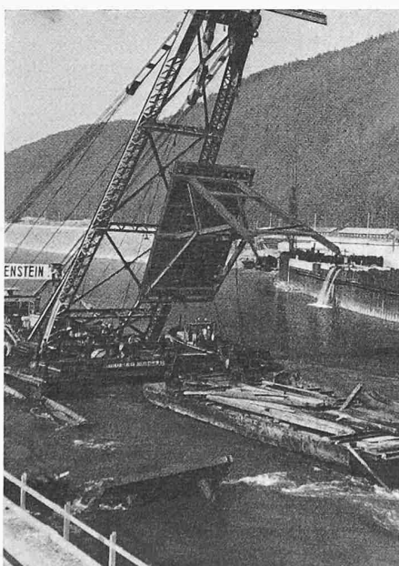
Bild 2. Versetzen eines Stauschildes
