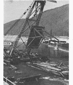
Bild 2. Versetzen eines Stauschildes
