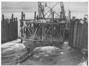
Bild 1. Montagetisch beim Schliessen eines Fangdammes
