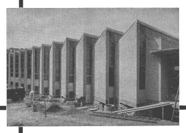
Eisenbetonbau, vollständig mit PORA-Platten ummantelt
