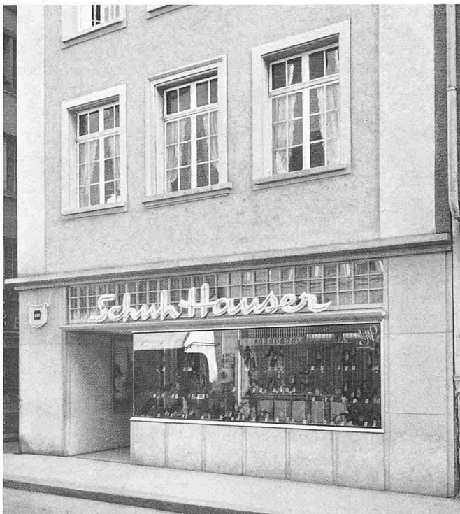
Ladenstrasse. Eckhaus. An der Ecke ist ein massiver Pfeiler nötig; die etwas massive Schrift liegt in der richtigen Höhe und ist deshalb für das Strassenbild unschädlich. Arch. R. Spoerli, Winterthur.
