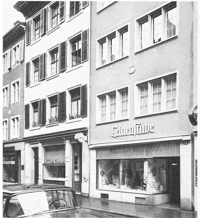
Ladenstrasse. Der Laden rechts (Arch. W. A. Gürtler, Winterthur) gut, die obere Beschriftung wahrscheinlich überflüssig. Links Gegenbeispiel mit zu hoher Ladenfront, der Oberteil durch Vorhang verhängt; die Pfeiler wirken nur als ein Element der Unruhe.
