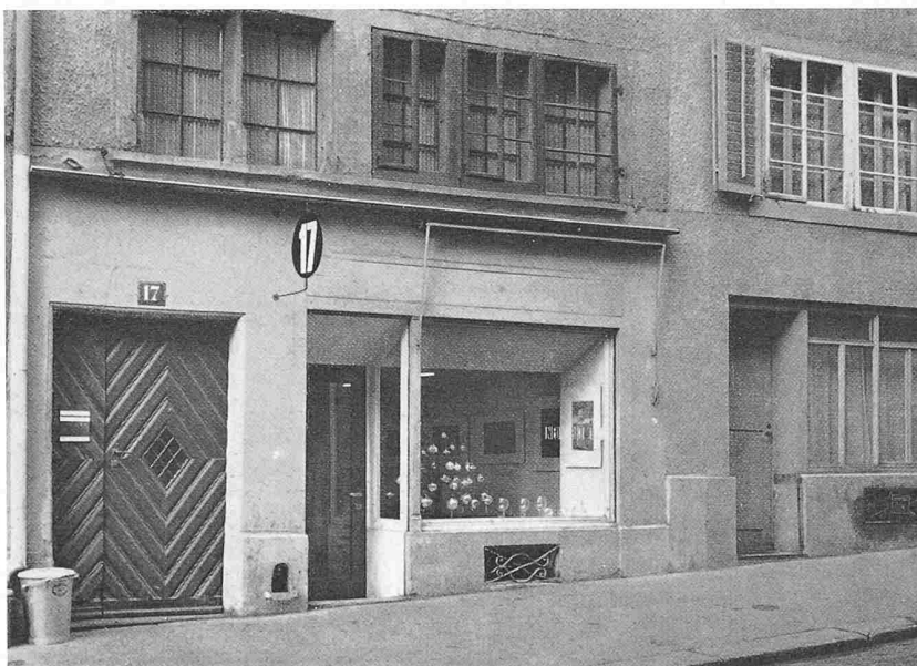
Altstadtstrasse mit Läden, nicht eigentliche Ladenstrasse. Nette Boutique; wenn die Verdachung noch herabgesetzt (besser beseitigt) würde, wäre alles in Ordnung. Neben der schönen alten Haustüre muss der Pfeiler natürlich stehen bleiben.
