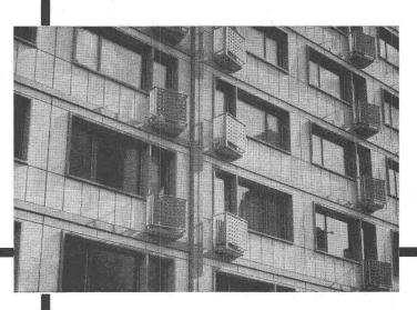
Ausfachung eines Beton-Skelettbaues
