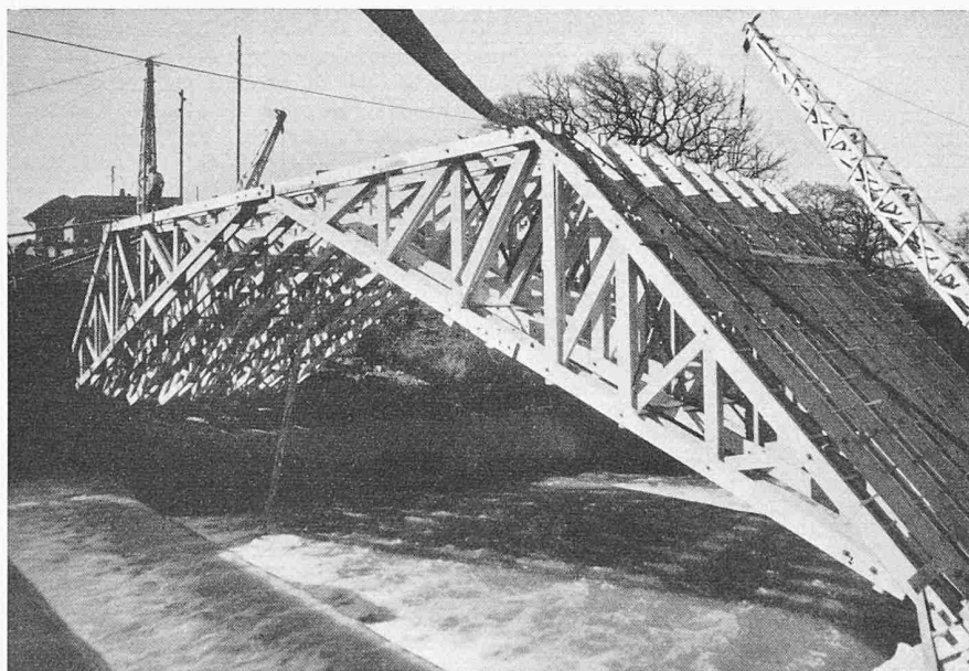
Bilder 7 und 8. Lehrgerüst in Ringdübelkonstruktion, Dreigelenkfachwerk von 35 m Spannweite; Binderhälften mit Holzderriek eingeschwenkt
