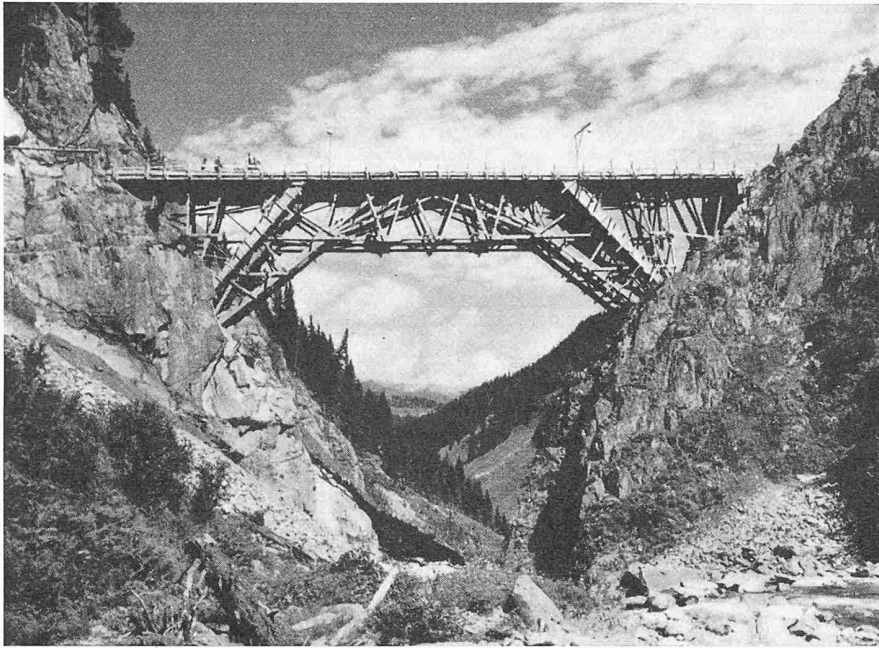
Bild 13. Lehrgerüst Val Nalps, im Freivorbau erstellt
