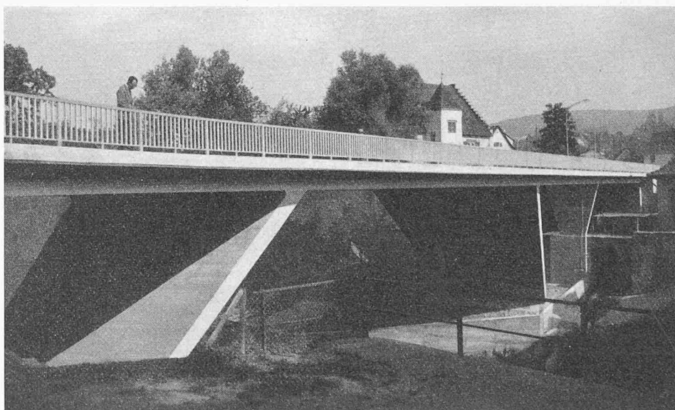
Bild 1. Untersicht der neuen Birsbrücke in Dornach vom linken Ufer, mit den Streben des Sprengwerkes und der Pendelstütze über den Kanaleinlauf
