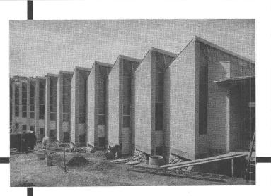
Eisenbetonbau, vollständig mit PORA-Platten ummantelt
