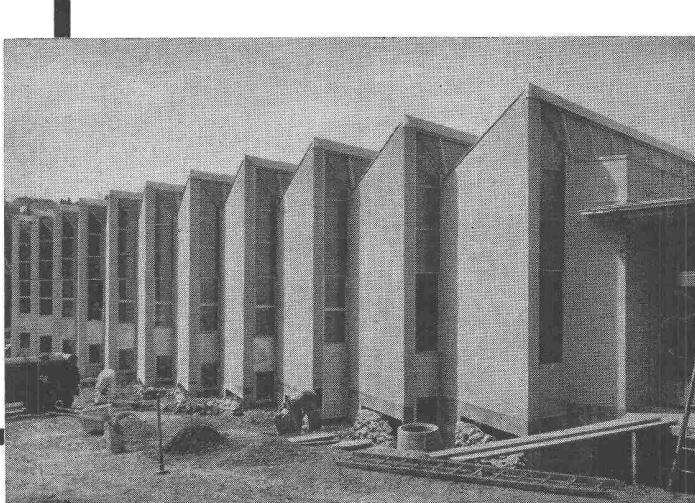
Eisenbetonbau, vollständig mit PORA-Platten ummantelt
