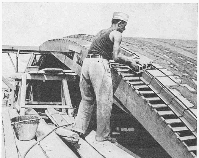
Bild 15. Ausführung der Schale mit einer beweglichen Lehre
