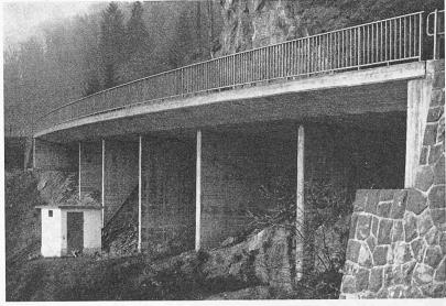
Bild 2. Lehnenbrücke an der neuen Walenseestrasse bei Murg SG
