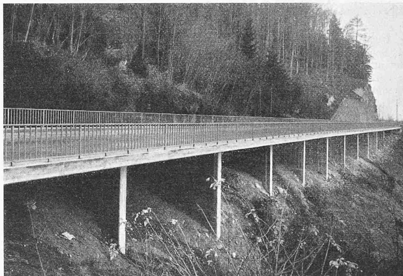
Bild 8. Lehnbrücke an der neuen Walenseestrasse
