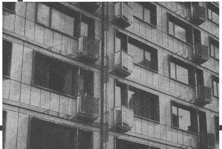
Ausfächung eines Beton-Skelettbau
