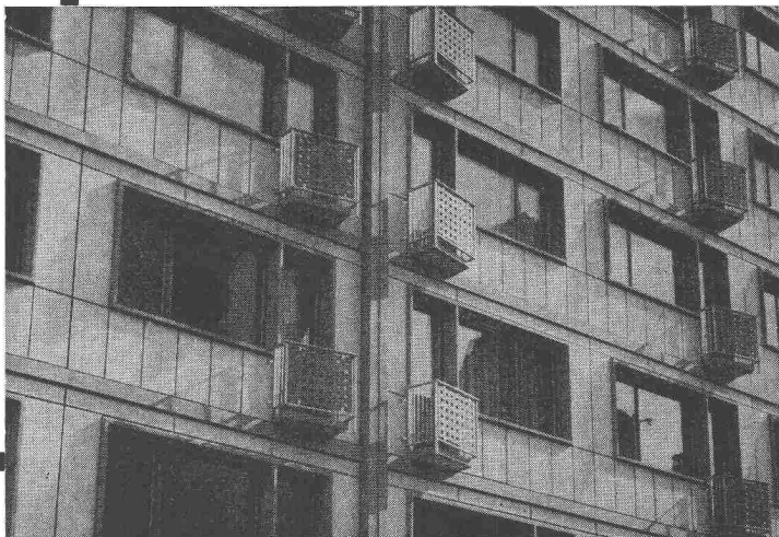
Ausfachung eines Beton-Skelettbaues
