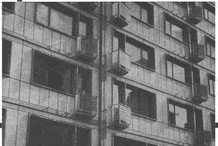
Ausfächung eines Beton-Skelettbau
