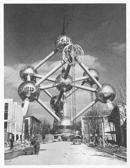
Das «Atomium» kurz vor seiner Vollendung (die Stützen aus Fachwerk dienen nur zur Montage). Gesamthöhe 102 m, Durchmesser der Kugeln 18 m, der Rohre 3 m, Länge der Rohre 29 m, Gerüst Spezialstahl, Verkleidung Aluminium. Das Innere der Kugeln und Rohre ausgenützt zu Ausstellungen über Probleme der Atomtechnik, in der obersten Kugel die Aufzugsmaschine «Schlieren», ein elegantes Restaurant und ein ringsumlaufender Aussichtsgang, in einer der untern Kugeln ein Bierlokal
