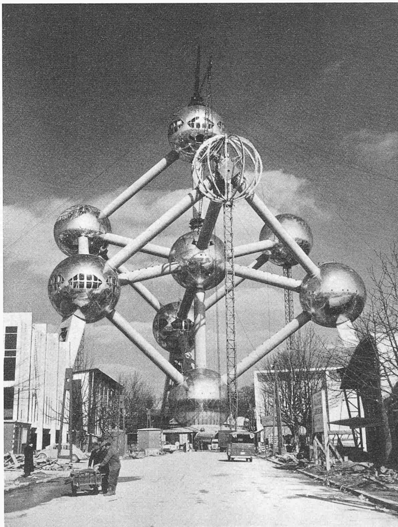
Das «Atomium» kurz vor seiner Vollendung (die Stützen aus Fachwerk dienen nur zur Montage). Gesamthöhe 102 m, Durchmesser der Kugeln 18 m, der Rohre 29 m, Länge der Rohre 29 m, Gerüst Spezialstahl, Verkleidung Aluminium. Das Innere der Kugeln und Rohre ausgenützt zu Ausstellungen über Probleme der Atomtechnik, in der obersten Kugel die Aufzugsmaschine «Schlieren», ein elegantes Restaurant und ein ringsumlaufender Aussichtsgang, in einer der untern Kugeln ein Bierlokal
