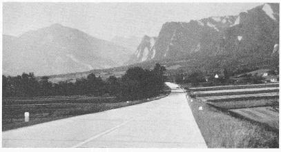
Bild 1. Autostrasse im Churer Rheintal, Ausschnitt aus der 1956 dem Betrieb übergebenen ersten Bauetappe Trimmis-Zizers, Weiss gestrichene Betonbretter, als Bordsteine in Abständen von 40 m versetzt, dienen der optischen Kurzführung bei Nacht und Nebel. Eine Wanne mit Vertikalausrundungsradius von 3400 m zwischen 4 % Gefälle und 3 % Gegensteigung, Uebergang in eine Linkskurve von 1400 m Radius mit einer Klothoide von 160 m Länge (im hügeligen Gelände knapp genügend)
