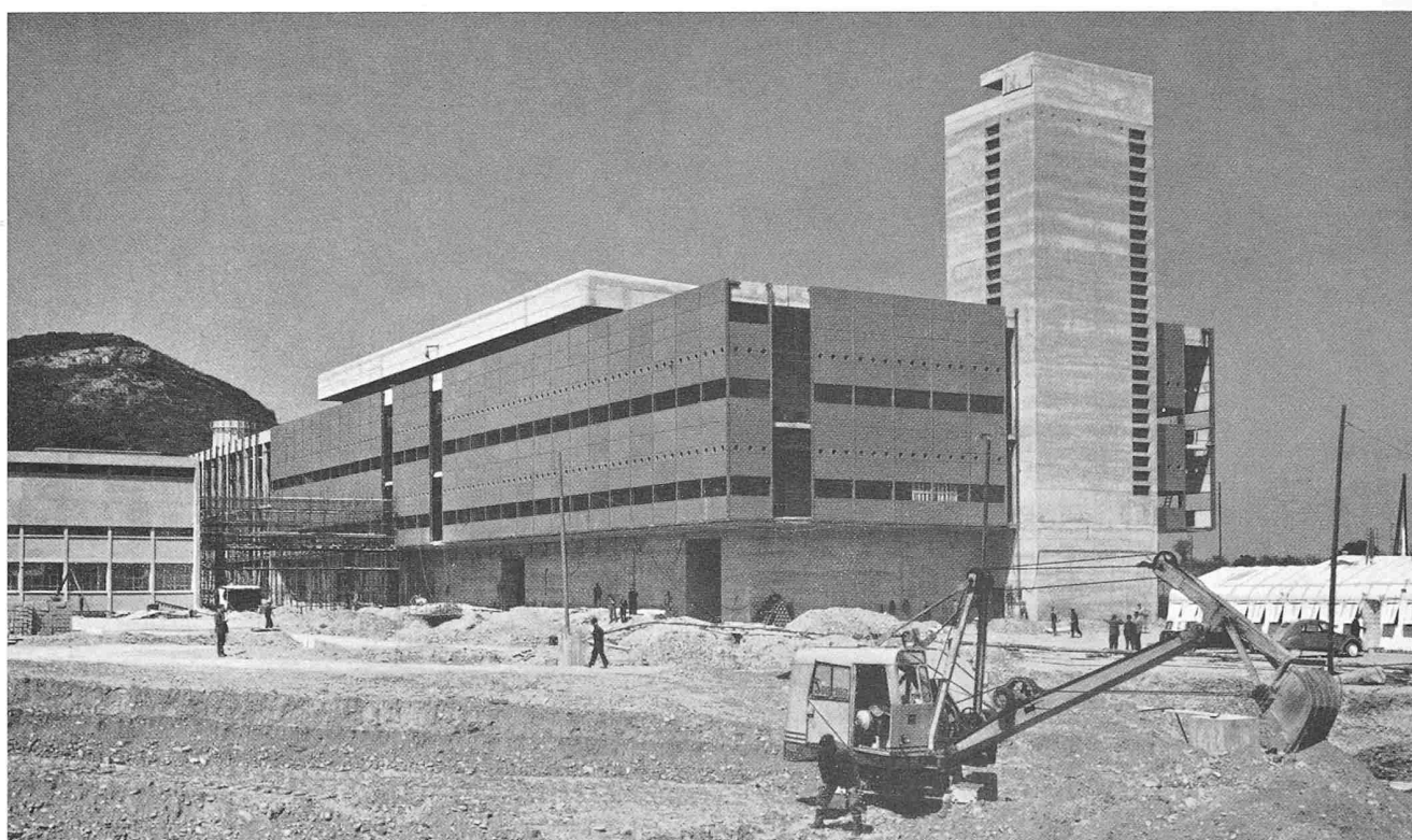
Bild 15. Das Gebäude der Plutonium-Gewinnungsanlage im Bau.
