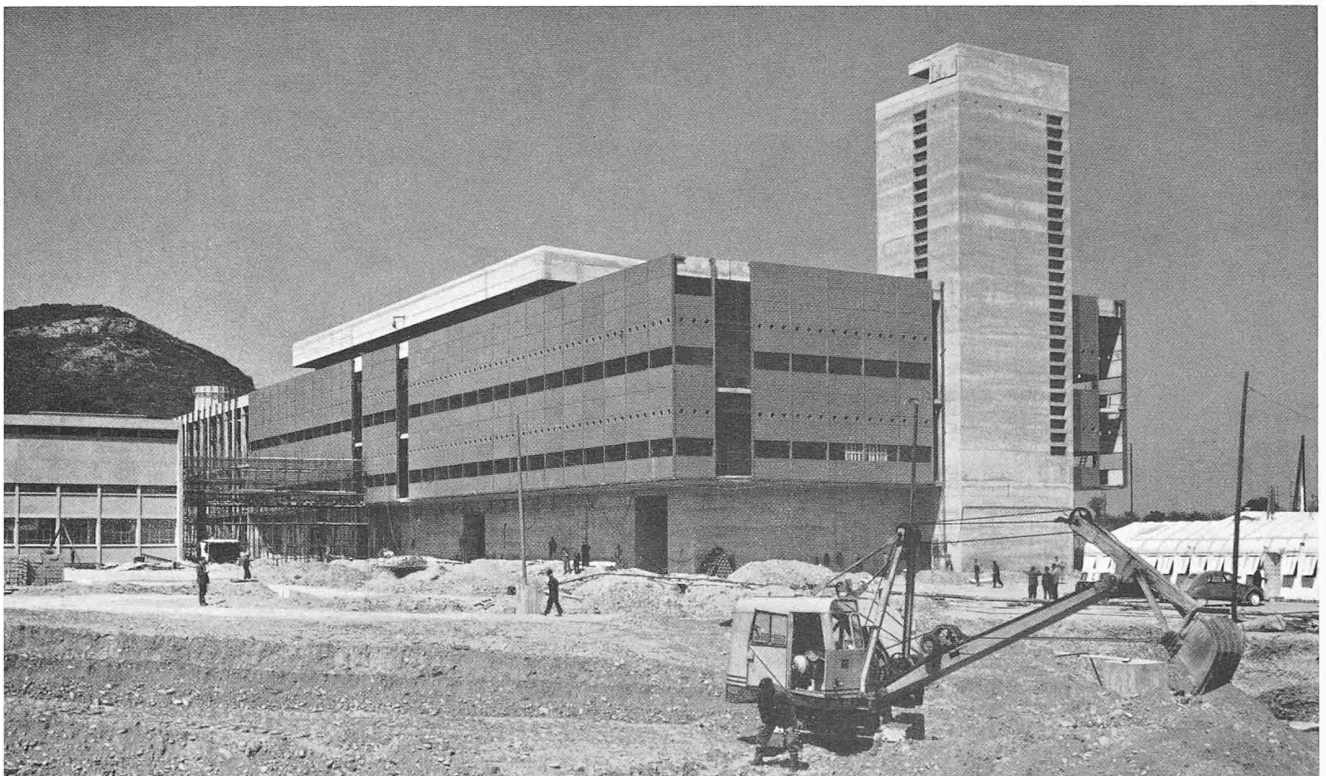
Bild 15. Das Gebäude der Plutonium-Gewinnungsanlage im Bau.
