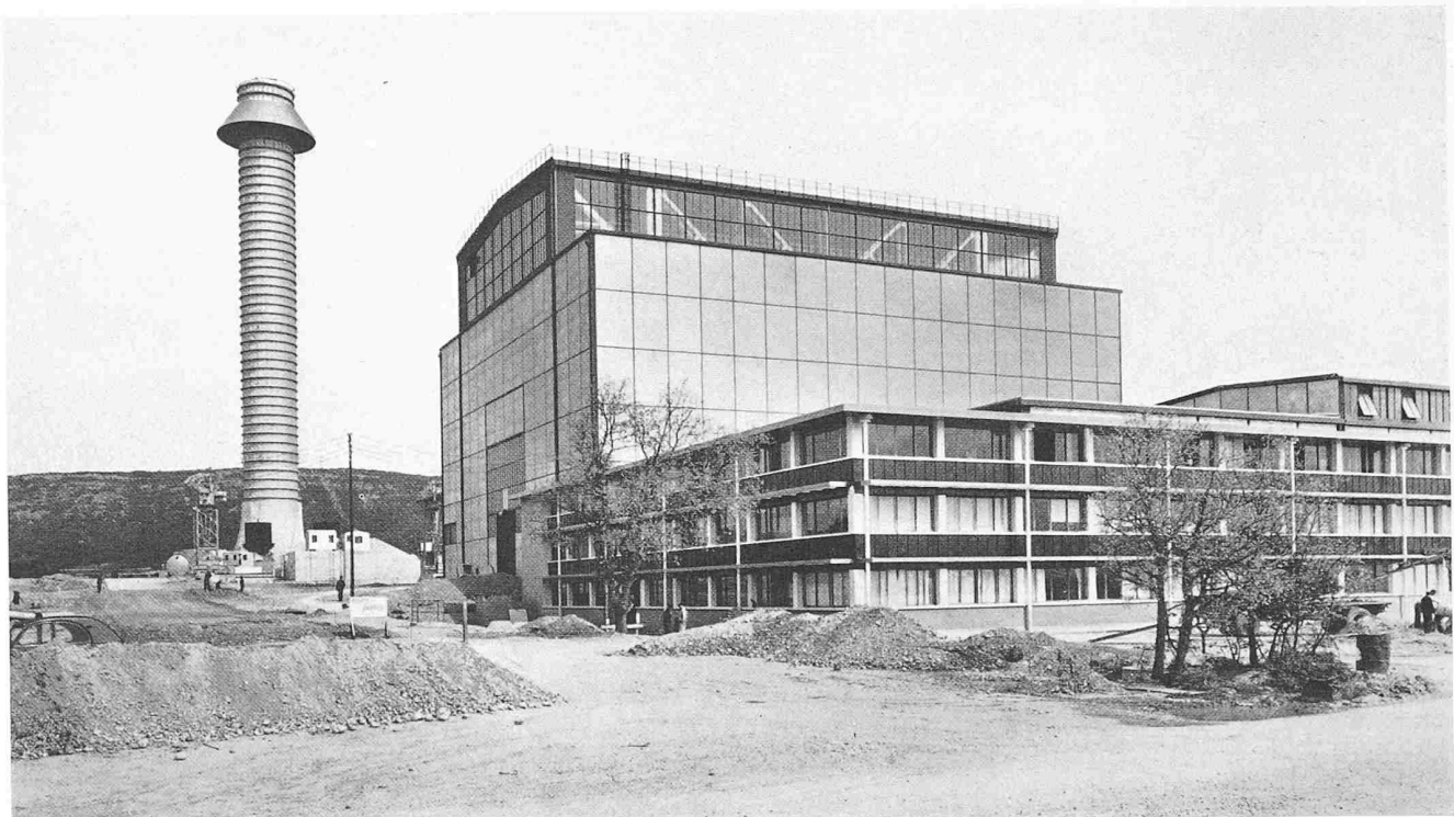
Bild 7. Das Gebäude des Reaktors G 1 , davor die Gebäude für die Hilfsanlagen, links der Hochkamin von 100 m Höhe.
