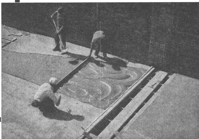
Flachdach zweischichtig, begebar
