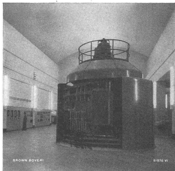
Bild 3. 23000-kVA-Synchronmotor, 1000 U/min, zum Antrieb einer zweistufigen Speicherpumpe, aufgestellt in einer Kavernenzentrale.
