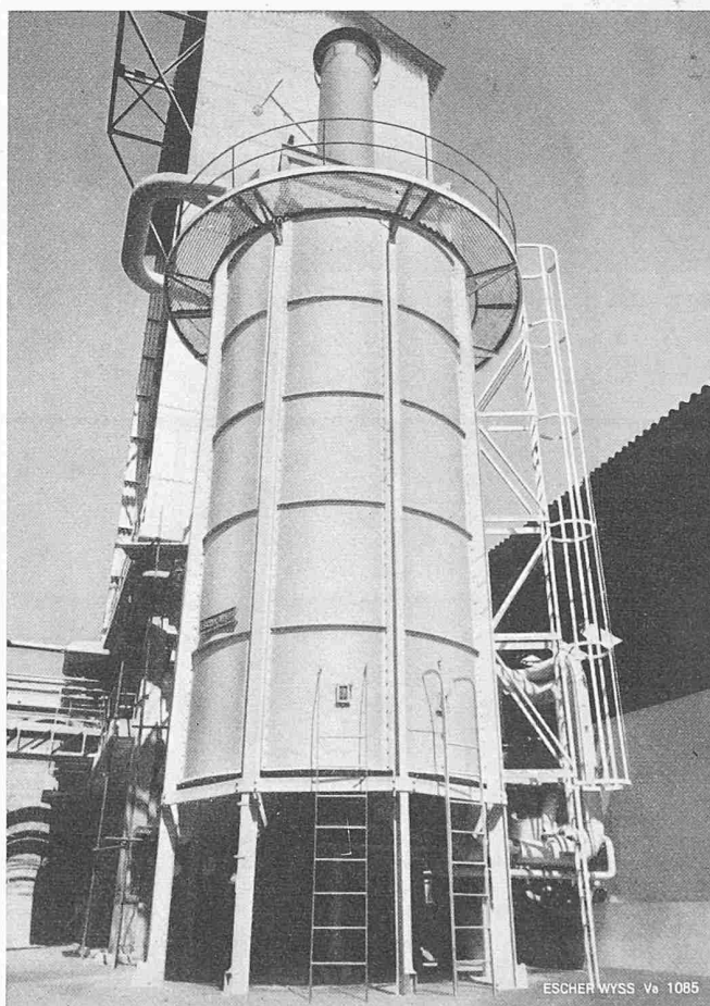
Bild 11. Escher-Wyss-Dowthermerhitzer mit Zwangsumlauf, separater Verdampfertrommel und zentraler, vertikaler Brennkammer
