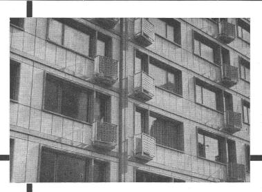
Ausfachung eines Beton-Skelettbaues
