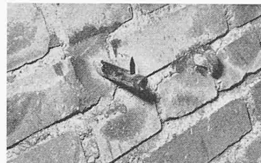
Bild 30 (links). Metallspitze in der Tunnelwand
