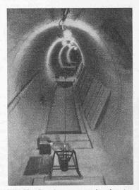
Bild 25. Streckenmessung im obersten Kontrollgang
