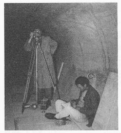
Bild 23. Polygonwinkelmessung auf speziellem Zentrierstativ
