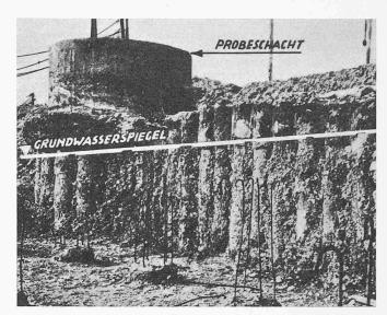
Bild 3. Ansicht der Bentonit-Bohrwand nach Ausheben der Baugrube für das Ausgleichsbecken des Wasserkraftwerkes Rocca d'Evandro am Volturno (Bild 5)
