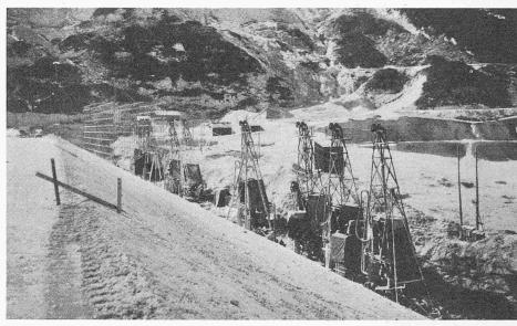
Bild 7. Um die Arbeiten am Diaphragma bis Ende 1954 beenden zu können, wurde eine Schutzhalle um die Bohrtürme herumgebaut
