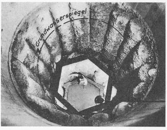
Bild 4. Blick von oben in den Probeschacht (s. Bild 5), der durch eine Bentonit-Bohrwand abgedichtet ist
