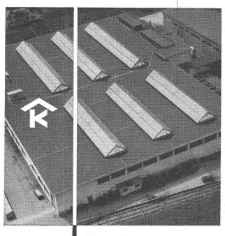
Kittlose Oberlichter für Shed- Sattel- und Pultdächer Parallelöffnende Ventilationsflügel «AIREX»
