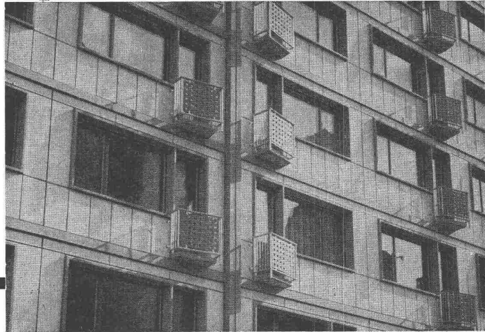
Ausfachung eines Beton-Skelettbauwerks
