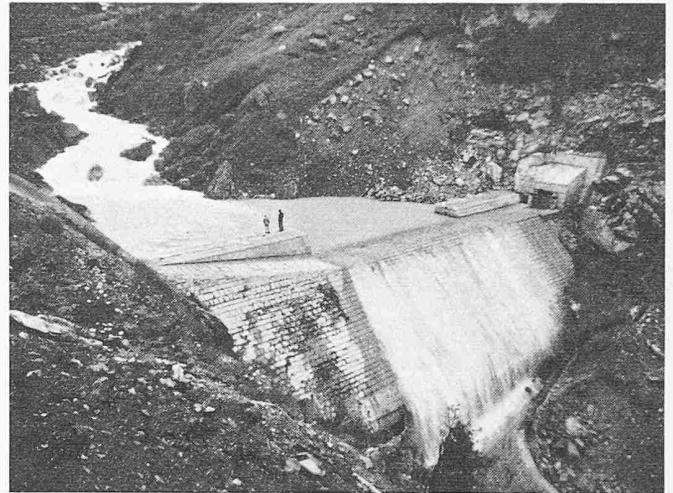
Bild 9. Das fertige Bauwerk der Steinwasserfassung
