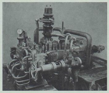
Bild 24. Ansicht der Turbine ohne Verschalung und Isolierung
