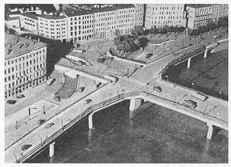
Bilder 19 und 20. Lyon, Knotenpunkt auf drei Ebenen der Expresstrassen Nord - Süd (mit Verbreiterung des Rhonequais) und West - Ost (in der Axe Tunnel des Rousses - Pont de Lattre-de-Tassigny)
