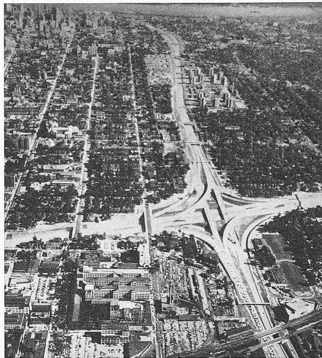
Bild 17. Detroit (Mich.), Knotenpunkt auf vier Ebenen der Expressways Edsel B. Ford und John C. Lodge
