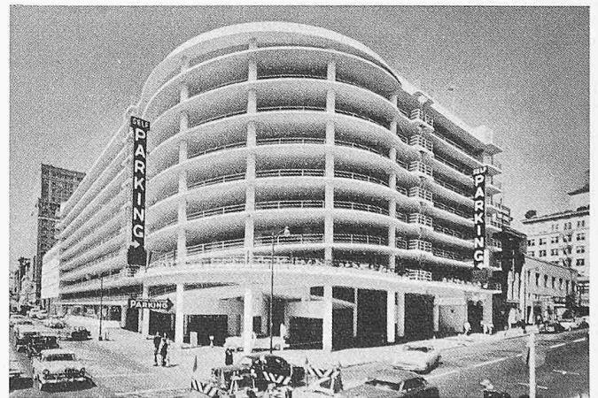
Bild 2. Ecke des Garagegebäudes mit Einfahrt und Aufstiegsrampe (unterster Teil der Abstiegsrampe im Erdgeschoss rechts der Bildmitte sichtbar).
