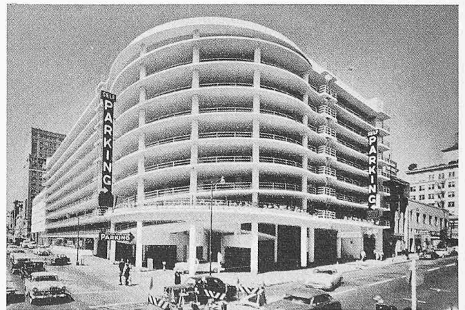
Bild 2. Ecke des Garagegebäudes mit Einfahrt und Aufstiegsrampe (unterster Teil der Abstiegsrampe im Erdgeschoss rechts der Bildmitte sichtbar).
