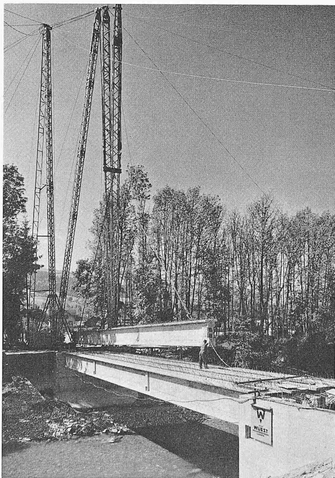
Bild 12. Hellbühlerbrücke über die Kleine Emme in Malters
