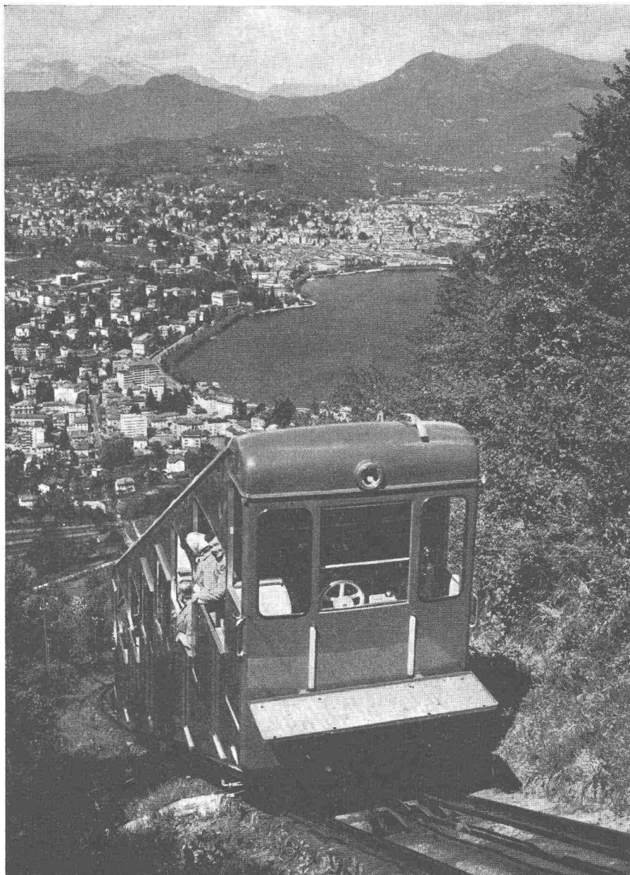
Standseilbahn Lugano—San Salvatore, welche Bell im Jahre 1890 erstellt und seither zu verschiedenen Malen zwecks Erhöhung der Transportleistung und Betriebssicherheit umgebaut hat, letztmals im Frühjahr 1957
