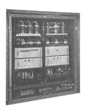
Elektronische Regelung. Erlaubt Vorwahl und Strombegrenzung. Anwendung bei sehr grossen Regelgeschwindigkeiten und hohen Genauigkeitsanforderungen
