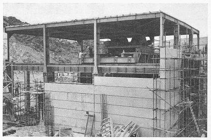
Bild 19. Maschinenhaus, vorfabrizierte Elemente des Daches und der Seitenwände montiert
