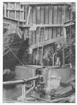
Bild 17. Isolieren der tiefsten Zone der Erosionsrinne
