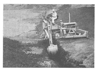
Der hydraulische HYSTER-Tieflöffel ermöglicht es, auch Grab- und Ausschachtungsarbeiten mit Ihren CATERPILLAR-Erdbewegungsmaschinen auszuführen.
