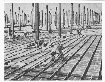
Fig. 3. On dispose les hourdis en carton
