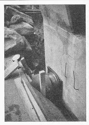
Bild 7. Ponte Sordo, verschiebliches Gelenk, Längsschnitt 1:8
