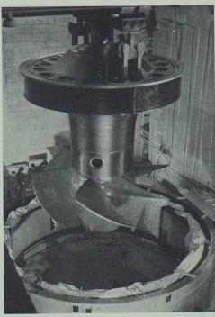
Bild 12. Einbau des Bell-Laufrades mit Turbinendeckel
