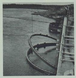
Bild 9. Einsetzen von Dammbalken vor die Wehröffnung
