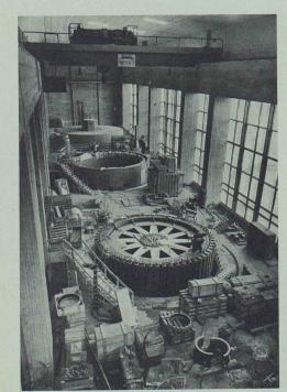
Bild 11. Maschinensaal bei der Montage des zweiten Aggregates
