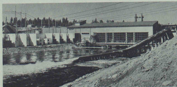
Bild 8. Kraftwerk von Unterwasserseite; rechts Flössrinne, links Schaltanlage
