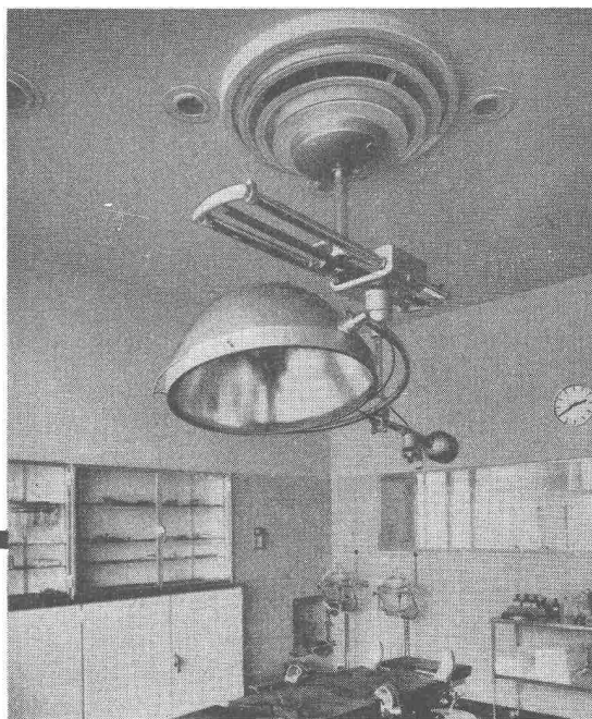
Klimaanlage «System Häusler» in Operationssaal eines Spitals
