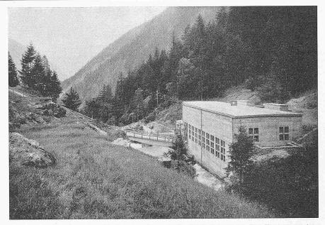
Bild 5. Maschinenhaus des Kraftwerkes Gampel III, Blick talabwärts. Die Vorderfront ist für einen Lawinendruck von  $3000~{\rm kg/m^2}$  berechnet
