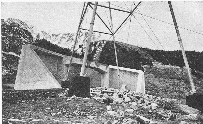
Bild 16. Blick auf den Eisenbetonkeil des Mastes oberhalb Acla mit Rahmenverbindung und Abstützungen von der Talseite
