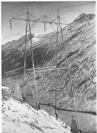
Tabelle 3. Lukmanierleitung; Arbeitsstundenaufwand für die Erstellung verschiedener Lawinenschutzkeile in Naturstein-Mauerwerk
