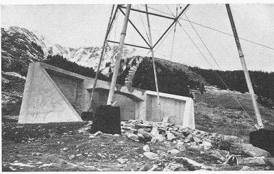
Bild 16. Blick auf den Eisenbetonkeil des Mastes oberhalb Acla mit Rahmenverbindung und Abstützungen von der Talseite
