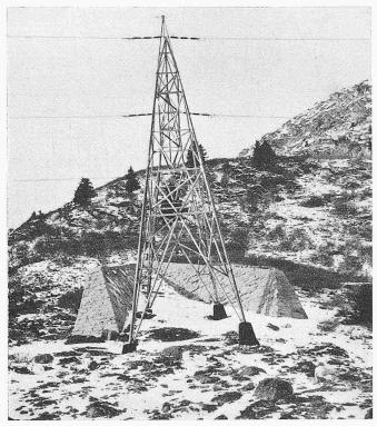
Bild 12. Blick auf den Mast mit Schutzkeil bei S. Gions von der Talseite
